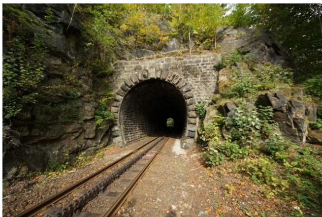
Obr. 3 Skalní zářez na vjezdovém portále
