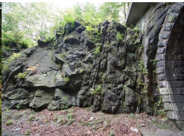
Obr. 4 Skalní zářez na výjezdovém portále
