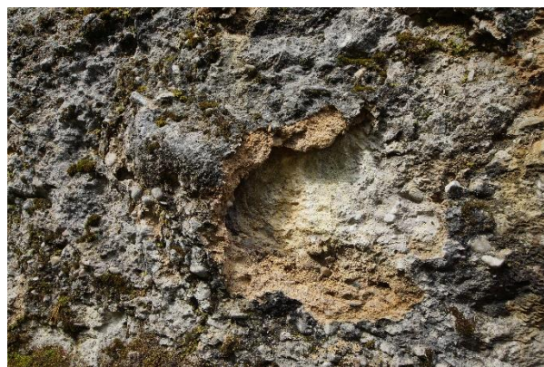
Obr. 11 Detail poruchy povrchu zárubní zdi
