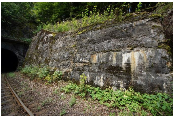
Obr. 10 Zárubní zeď na výjezdovém portále
